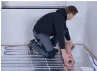
CompactFloor DIRECT 1.5 mit dem Aluminium nach oben, in einer Ecke beginnend, im Raum verlegen.
