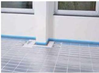
Geeignete druckstabile Trockenbau-Fußbodenheizung verlegen und vollflächig mit dem Untergrund verkleben.
