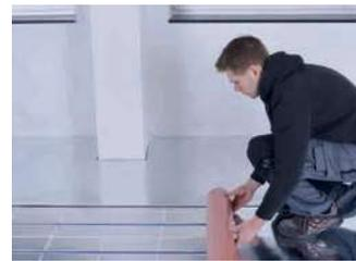
CompactFloor DIRECT 1.5 Bahn für Bahn spannungsfrei verlegen. Stoßkanten dabei nicht überlappen.
