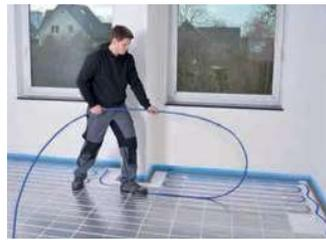
Anschließend das Rohr nach Herstellerangaben in einem großen Bogen von oben spannungsfrei verlegen.
