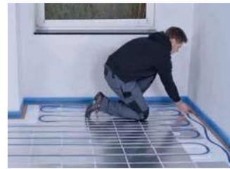
Randdämmstreifen vor der Verlegung von CompactFloor DIRECT 1.5 bündig zur Fußbodenheizung abschneiden.
