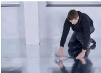
Alle Stoßkanten mit CompactFloor DIRECT 1.5 Aluminiumklebeband zur Abdichtung und optimalen Wärmeübertragung verkleben.
