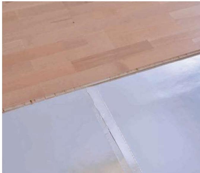
CompactFloor DIRECT 1.5 ist nach der Verlegung direkt begehrbar. Das Fertigparkett gemäß Herstellerangaben schwimmend verlegen.
