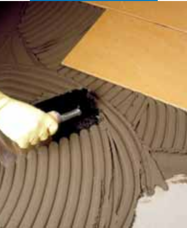
Met een lijmkam aanbrengen van Elastorapid op een cementdekvloer
