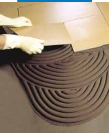
Aanbrengen van gres porcellanato op een met Mapelastic waterdicht gemaakte dekvloer
